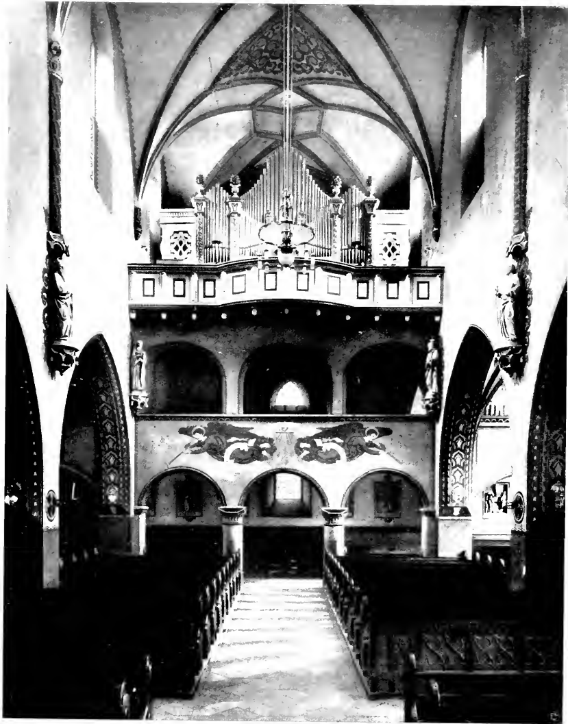
STADTFARRKIRCHE AICHACH RESTAURIERUNG ARCHITEKT RICHARD BERNDL, MALER KLEMM
